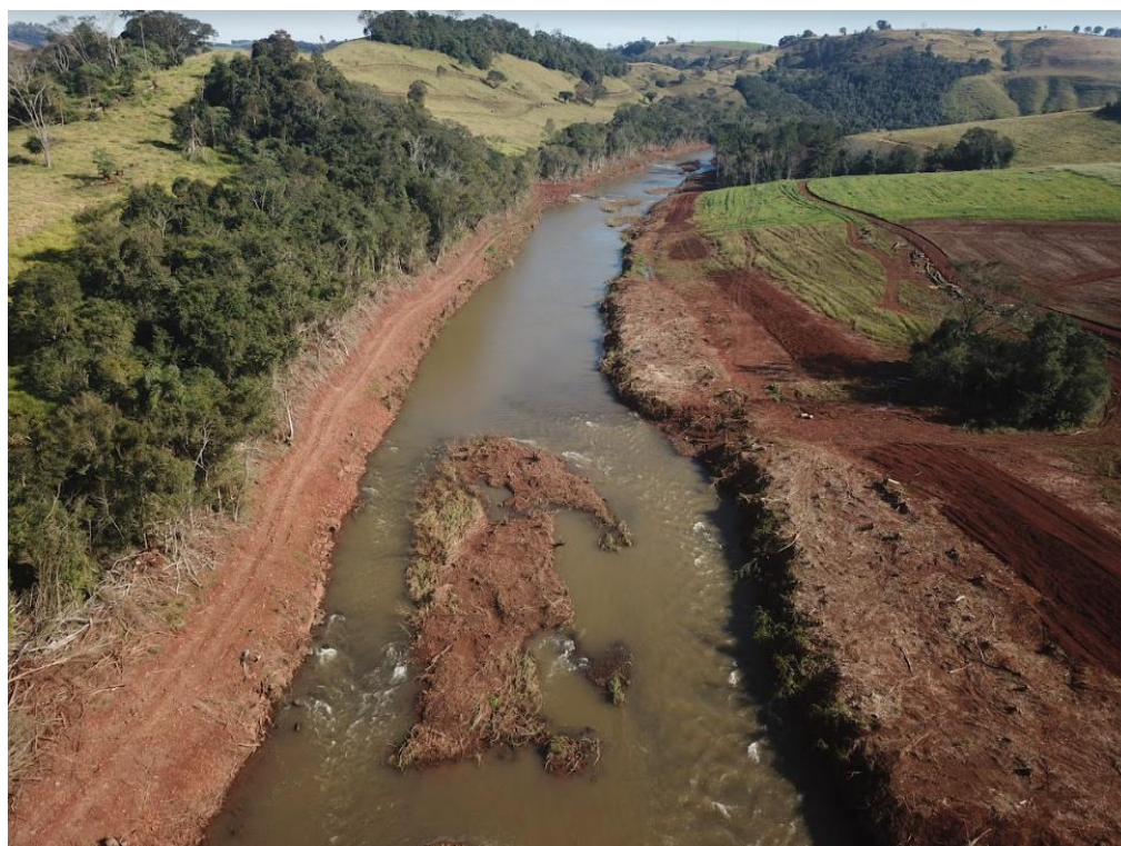
Figura 14 - Frente de supressão na área do futuro reservatório
